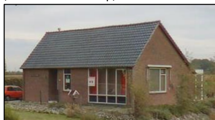
Bovensmilde – Hoofdweg 25 (nieuwbouw na sloop)
