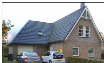
Beilen – Esweg 94 (nieuwbouw na sloop)
