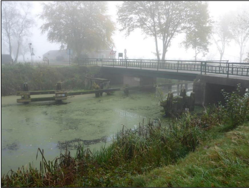
Figuur 3.19 Draaibrug over het Linthorst-Homanskanaal met remmingswerk en (vervallen) loopbrug (foto: E.A.M. de Boer)
