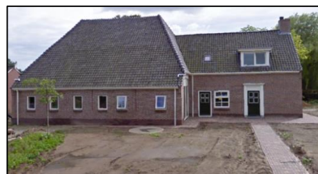
'Seubring' zijgevel na verbouwing
