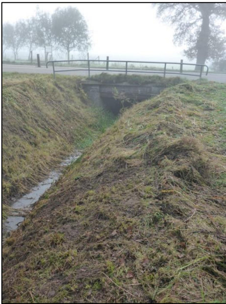
Figuur 3.20 Duiker in de Beilerweg (foto: E.A.M. de Boer).
