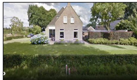
'Seubring' voorgevel na verbouwing
