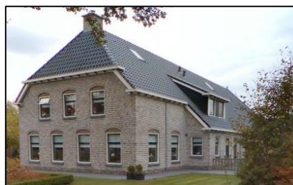
Bovensmilde – Kanaalweg 177 (nieuwbouw na sloop)
